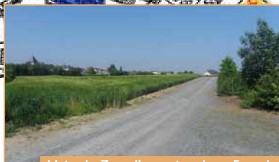
Voie de 7 m d'emprise dont 5 m de chaussée.
