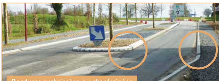
Bordures surbaissées ou chanfreinées
